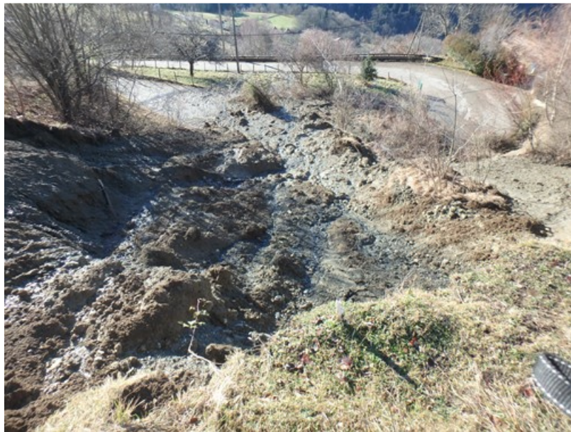
Figure 2 : Vue vers l'aval de l'arrachement supérieur au matin du 06/01/2018
