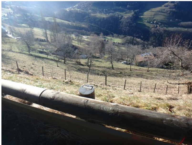
Figure 7: Vue vers l'aval, depuis la chaussée fissurée, sur les deux habitations
