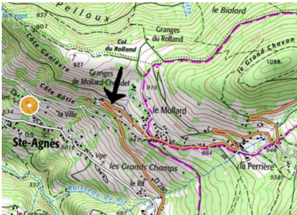
Figure 1: Localisation du glissement du talus amont de la voirie
