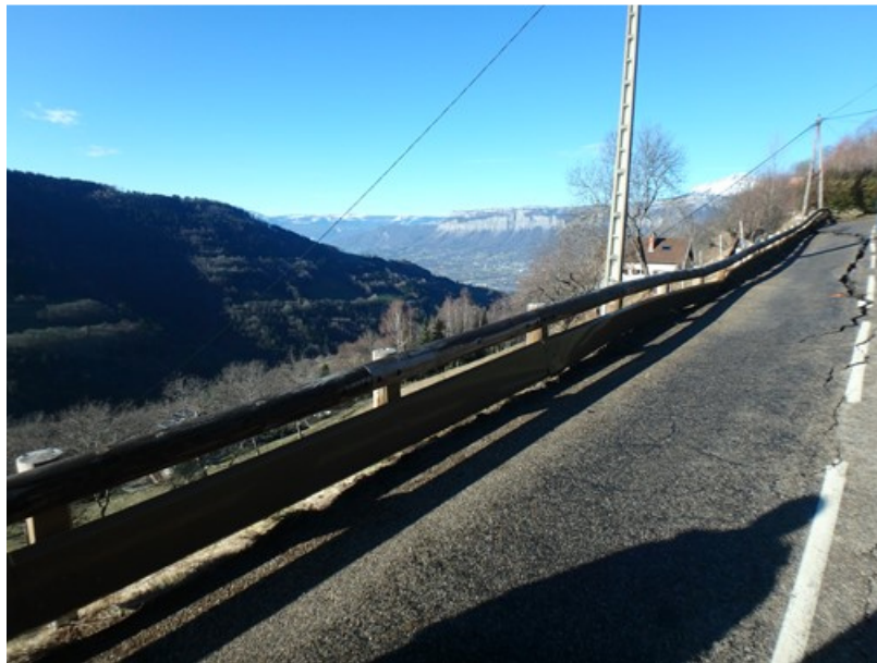
Figure 4 : Photo de la fissure et du poteau EDF au matin du 06/01/2018
