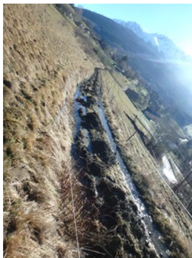
Figure 5 : Chemin antenne Est gorgé d'eau
